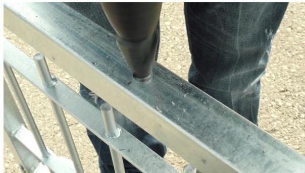
Después de haber medido la distancia correctamente, desengancha la puerta y transfiera las marcas a la parte abajo de la puerta. A continuación realiza los agujeros con una taladradora de metal – perfora el marco de la puerta completamente. Asegúrate que la perforación esté realizado en línea recta. Ahora hay que ensanchar los agujeros en la parte abajo hasta unos 12 a 14 mm utilizando una broca escalonada. Este paso es necesario para que se puedan posicionar la **llave de tubo nr. 10**.
