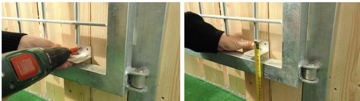
Después de haber medido la posición correcta. Fija la escuadra 1 utilizando los materiales y herramientas adecuados (p. ej. tornillos o tacos). En nuestro ejemplo los dos tornillos adjuntados son suficientes.
